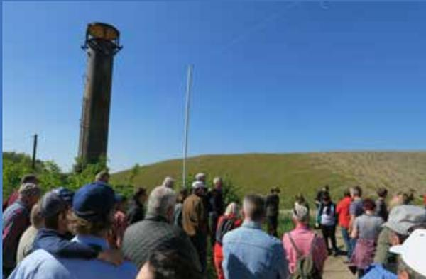
*Hochtemperaturfackel zum Abbrennen des Deponiegases. Es fällt kaum noch Gas an.*
