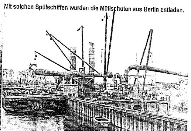
Mit solchen Spülschiffen wurden die Müllschuten aus Berlin entladen.
