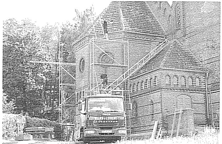
Einrüstung der Kirche. Schon im Juli 2010 wurde die Kirche eingertüstet und anschließend die alte Dachbedeckung entfernt. Bevor ein neues Dach gedeckt werden kann, mussten dann Zimmerleute und Mauerer Schadhafes ersetzen, Bestehendes restaurieren und alles für die Neuindeckung des Daches vorbereiten, um mit dem dringend notwendigen Schutz vor eindringendem Wasser, auch das historische Aussehen des Kirchendaches wieder herzurichten. Fotos: Höfgen
